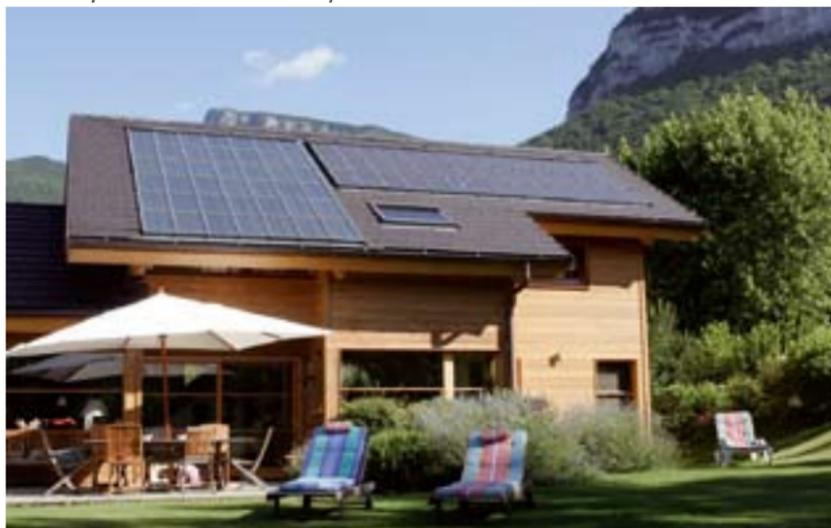
La **surface** de capteur nécessaire oscille entre 3 et 5 m<sup>2</sup> pour un CESI (qui pourra couvrir environ 60 % des besoins en eau chaude d'une famille de 4 personnes), entre 10 et 20 m<sup>2</sup> pour un chauffage (30 à 40 % des besoins couverts). Le complément est assuré par un **système d'appoint**. Le relais entre solaire et appoint se fait de façon à optimiser l'emploi de l'énergie solaire.
